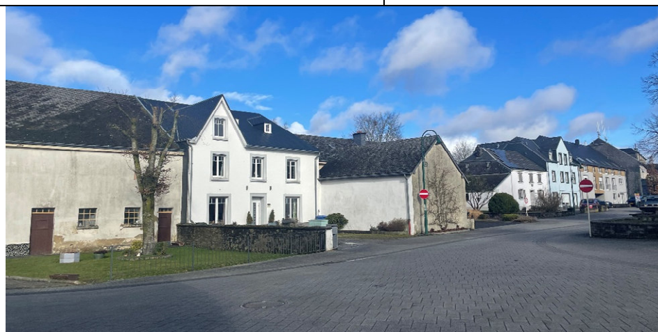
Figure 13: construction en face de l'entrée du PAP
